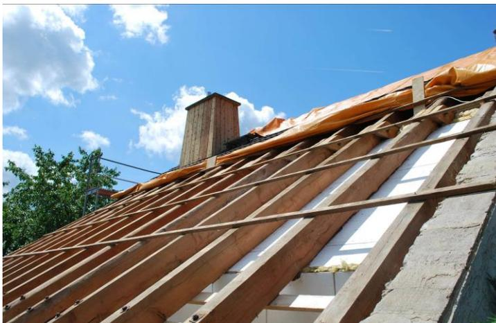
**Eine von vielen Sanierungsbaustellen im Land:** In diesem Dach sollen Dämmung und Luftdichtung von außen eingebracht werden.
