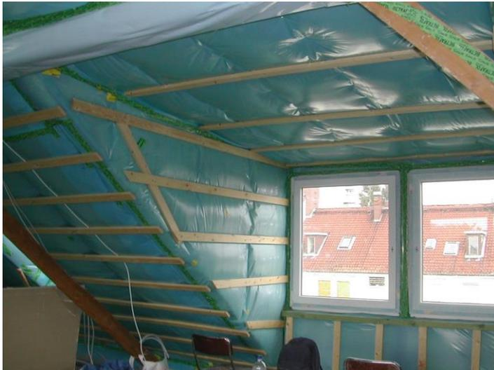
**Undichtheit durch Unwissenheit:** Trotz sauberer handwerklicher Arbeit kann Luftdichtheit nicht entstehen, wenn – wie in diesem Beispiel – die alte Holzbalkendecke unter dem Fußboden unbeachtet bleibt. Eine Leckagesuche vorab hätte den zusätzlichen Sanierungsbedarf rechtzeitig aufgedeckt.
