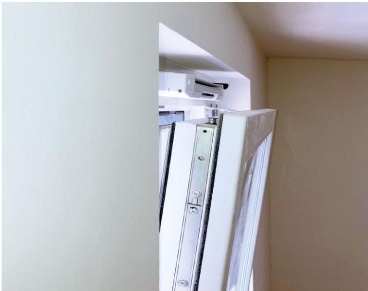
**Arbeitserleichterung:** Außenbauteil-Luftdurchlässe (ALD) für die freie Lüftung werden für den Blower-Door-Test zum öffentlich-rechtlichen Nachweis nach GEG nicht mehr abgedichtet.
