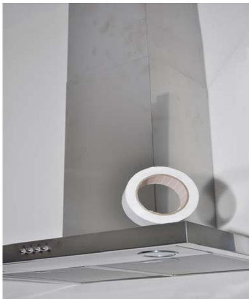
**Offen lassen, verschließen oder ganz abdichten?** Die Frage, wie man bei Luftdichtheitstests mit Gebäudeöffnungen wie dieser Abzugshaube umgehen soll, wird auch mit der jüngst verkündeten EnEV 2014 nicht klarer, befürchtet der Fachverband Luftdichtheit im Bauwesen e. V.
