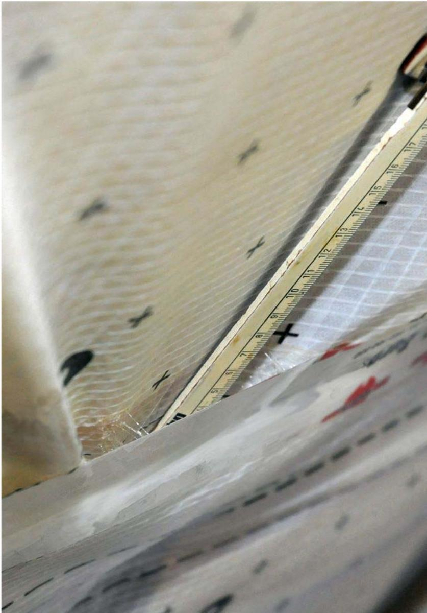
**Ist diese fehlerhafte Verklebung kritisch?** Je nach Blickwinkel und Einzelfall kann man zu unterschiedlichen Ergebnissen kommen. So ist es durchaus möglich, dass sie weder nennenswerte Lüftungswärmeverluste noch Zugluft verursacht und dennoch Ursache eines Bauschadens wird.
