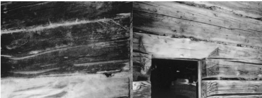
Bild 1.1: Bei Holzblockbauten diente mitunter Moos und Lehm als Dichtmaterial für Fugen und Ritzen. (Foto: Eicke-Hennig)
