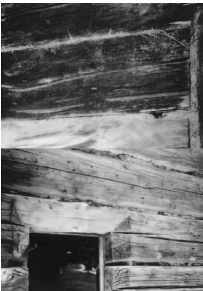
Bild 2.1: Bei Holzblockbauten diente mitunter Moos und Lehm als Dichtmaterial für Fugen und Ritzen. [Foto: Eicke-Hennig]
