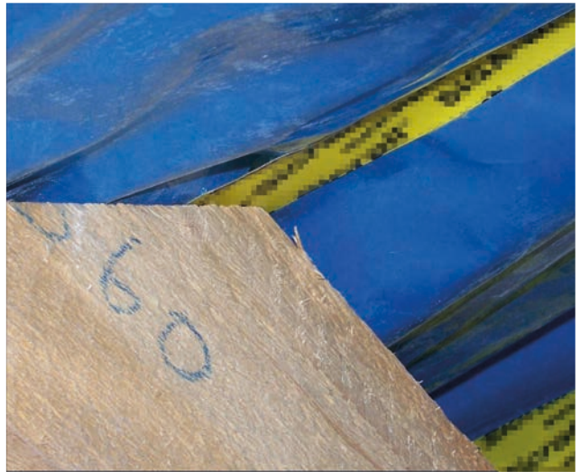
Bild 3.14b: Typische Fehlstellen in der Folienverklebung
