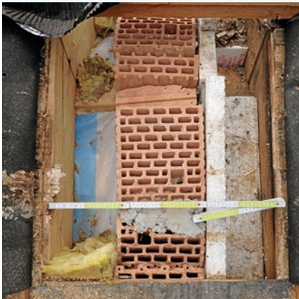
Öffnung der Mauerwerkskrone
